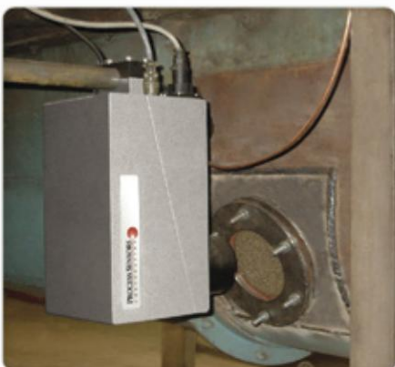
Pomiar wilgotności przez okno szklane
